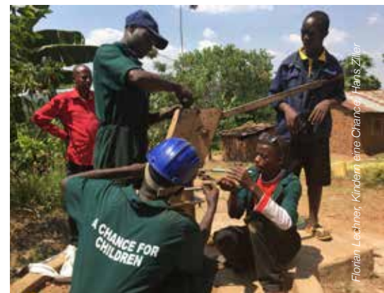
Bei notwendigen Reparaturen werden unsere Brunnenreparaturteams verständigt, die aus ehemals unterstützten Jugendlichen von „Kindern eine Chance“ bestehen, die nun hier Arbeit gefunden haben.
